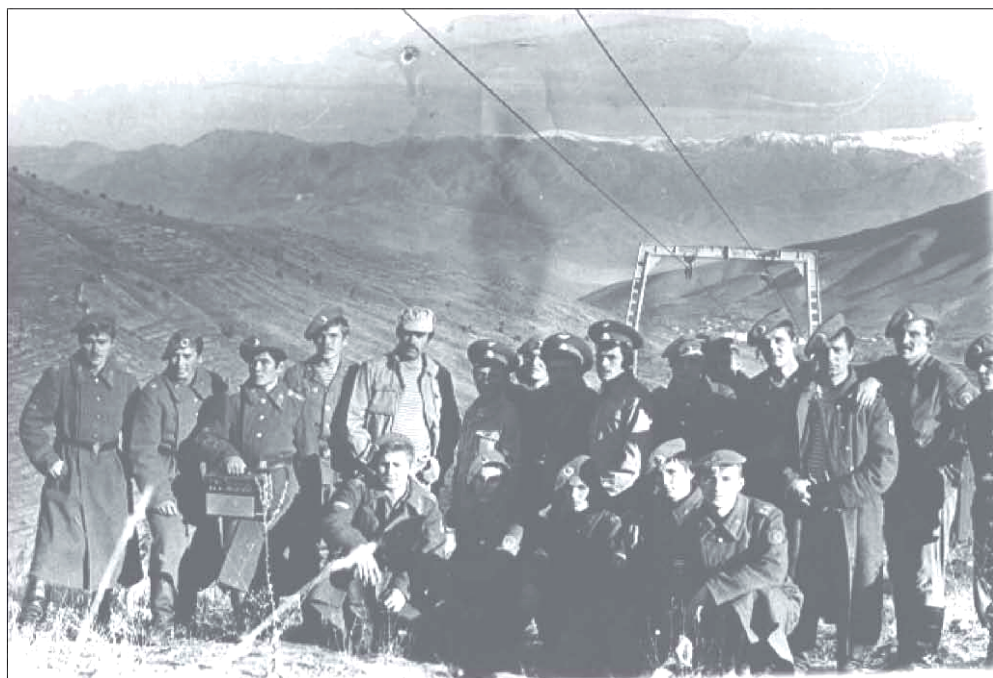
Фото под канатной дорогой
