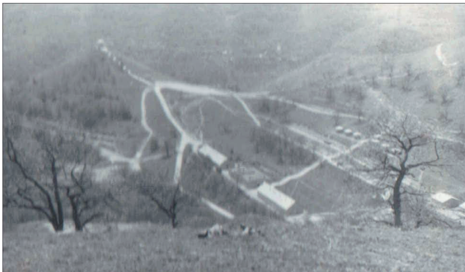
Вид на лагерь Кироваканского горного учебного центра.
