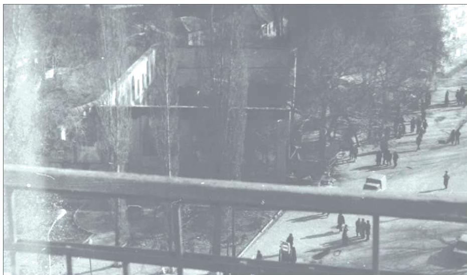
Сгоревшее здание универмага
